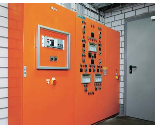
Dans les grosses installations, le système de régulation est monté dans une armoire de commande séparée.
