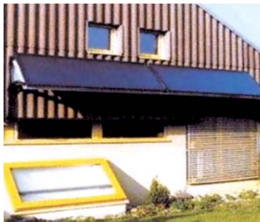
Montage en façade
