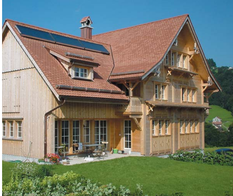
Montage sur le toit
