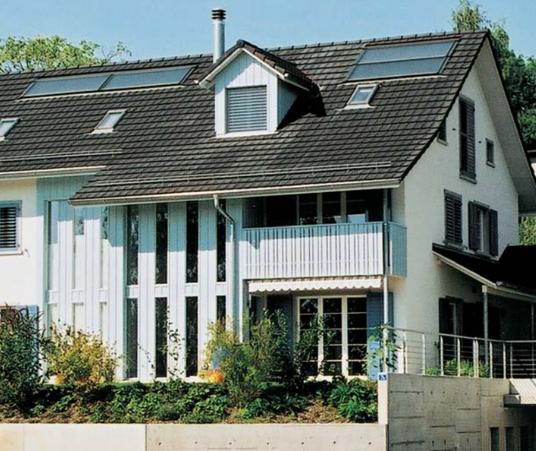
Montage intégré dans la toiture
