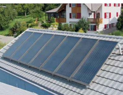
Maison familiale à Niederneunforn. 7 capteurs Hoval plans sur toit en tuiles. Chauffage d'appoint Hoval MultiJet®.
