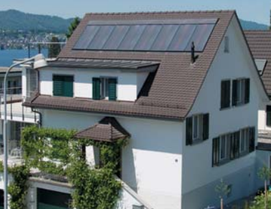
Maison à deux appartements à Erlenbach ZH. 8 capteurs solaires Hoval intégrés dans le toit avec chauffage d'appoint Hoval TopGas®.
