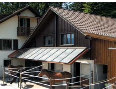
Maison familiale avec écurie à Wolfhausen. 8 capteurs solaires Hoval intégrés dans le toit sous la forme d'un auvent. Chauffage auxiliaire: chaudière à mazout existante.
