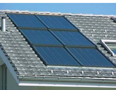
Maison familiale avec 6 capteurs Hoval IDKM intégrés dans le toit. Chauffage d'appoint à mazout.
