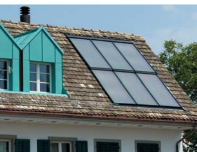
Double maison familiale à Stäfa. 6 capteurs Hoval IDKM superposés et intégrés dans le toit.
